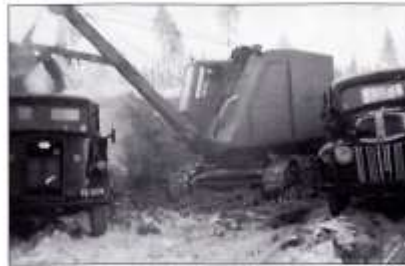
Teräsmies 3-4. Teräsmies 5/8 5-tie työmaalla Mainualla vuonna 1956. Autot Ford Hames ja kermanokka Ford.
